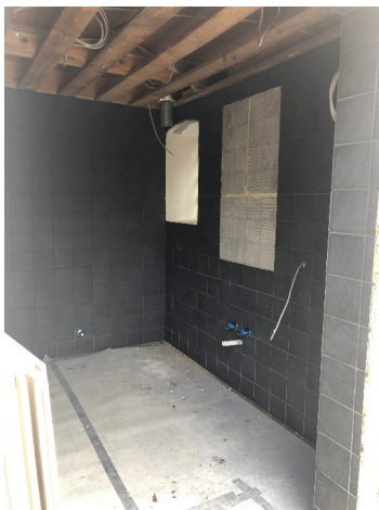
Nye toiletter på vej på Vigs østre kirkegård
